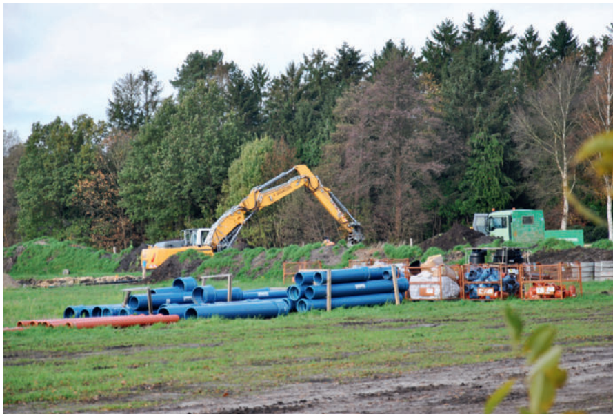
Derzeit werden die notwendigen Versorgungsleitungen verlegt.
